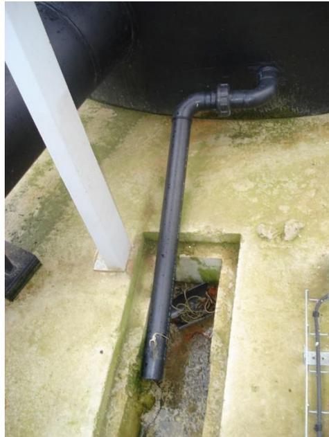
Figure 43 – Vidange du bassin de stabulation (principe)
