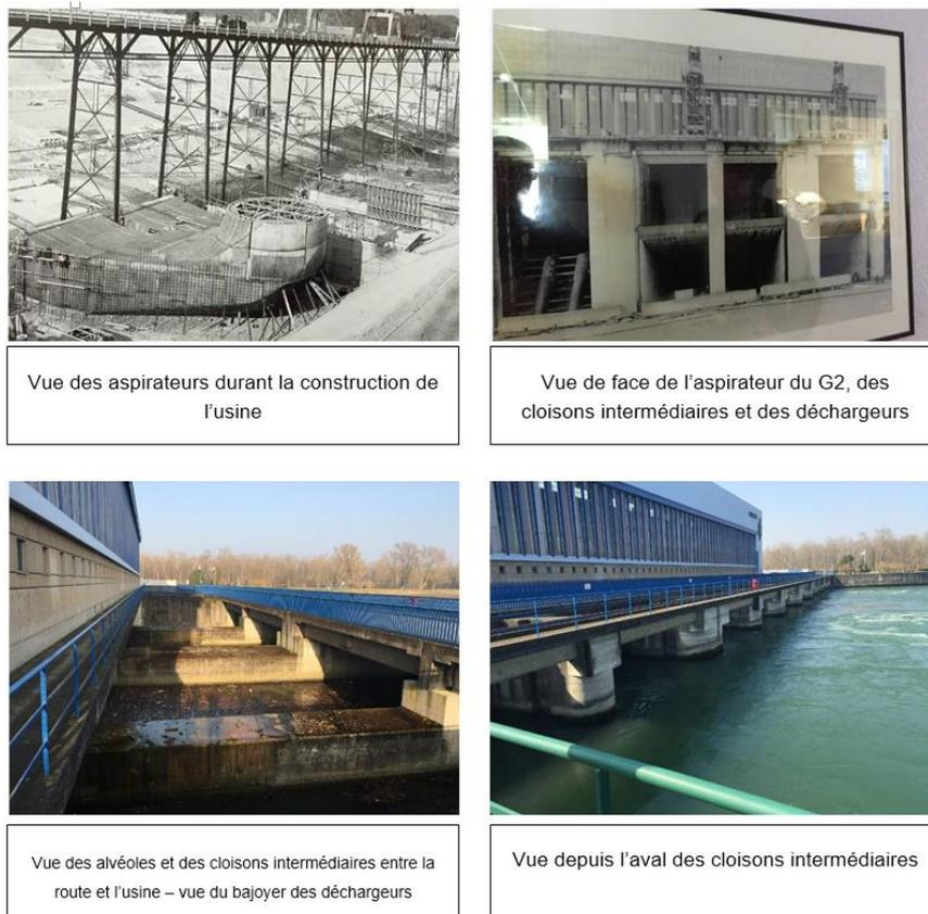
Figure 16 – Vue des aspirateurs, des alvéoles et des loges
